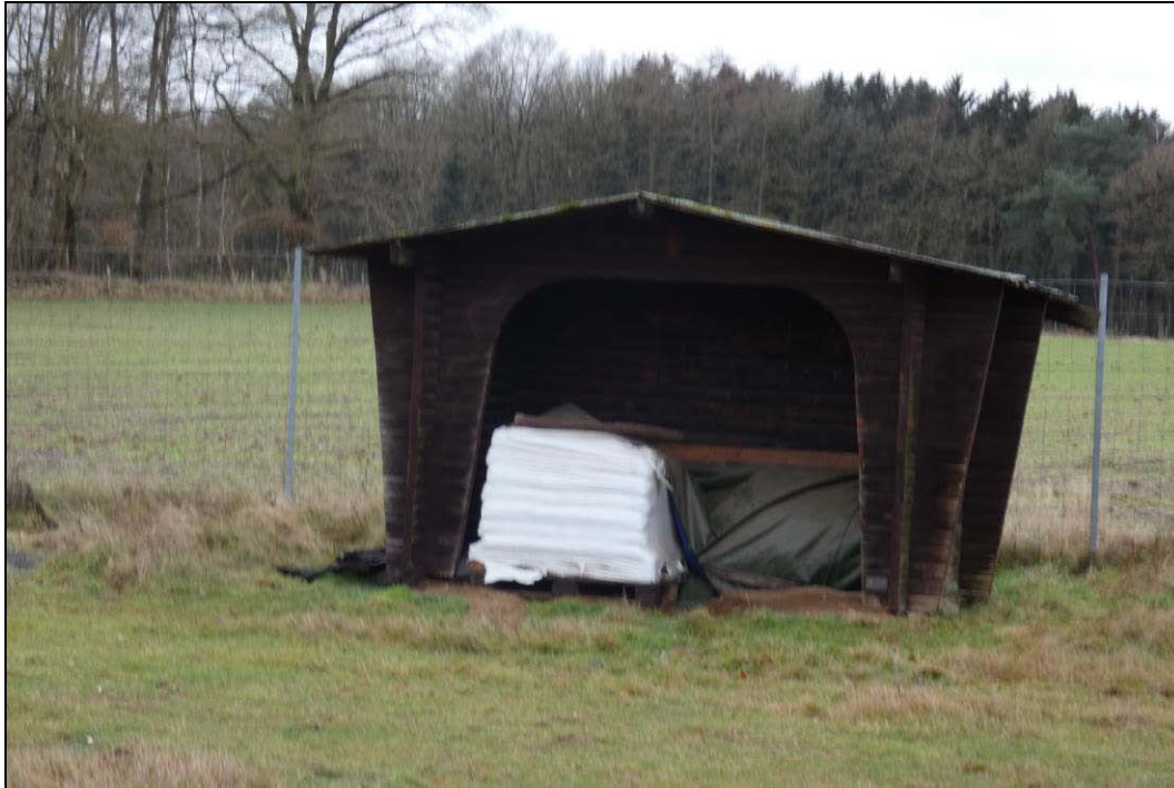
Abbildung 5: Ehemaliges Bushäuschen im Plangeltungsbereich.
